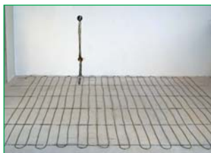
◀ Начало укладки кабеля Весь кабель уложен ▼
