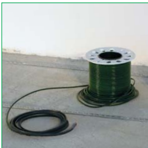
▲ Монтажная лента уложена
