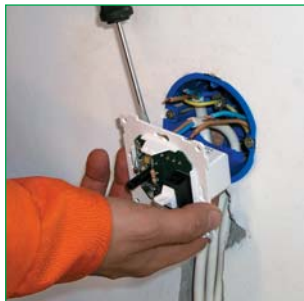
▲ Подключение терморегулятора
